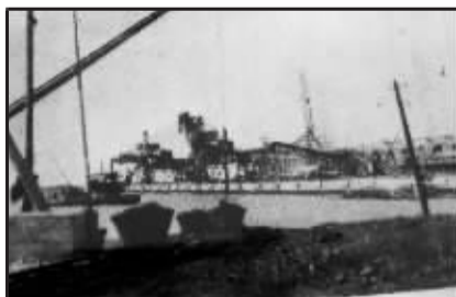
日寇占领时期八所港码头作业进行中。
