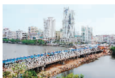
新风大桥南北幅桥面架通
