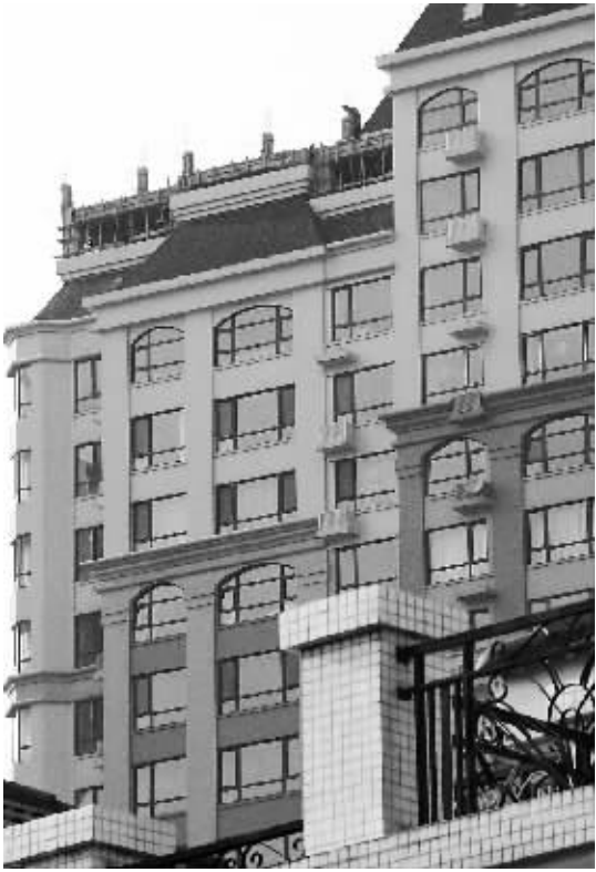
工人在违章建房的高层楼房上施工(4月14日摄)。新华社记者马扬摄
