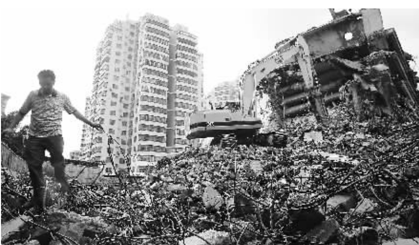
“亿城家园”加紧拆除
