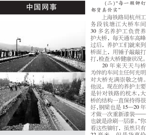
7月23日,建成已74年的钱塘江大桥依然“坚强”(上图),而建成不过14年的钱江三桥却塌了(下图)。 新华社发
