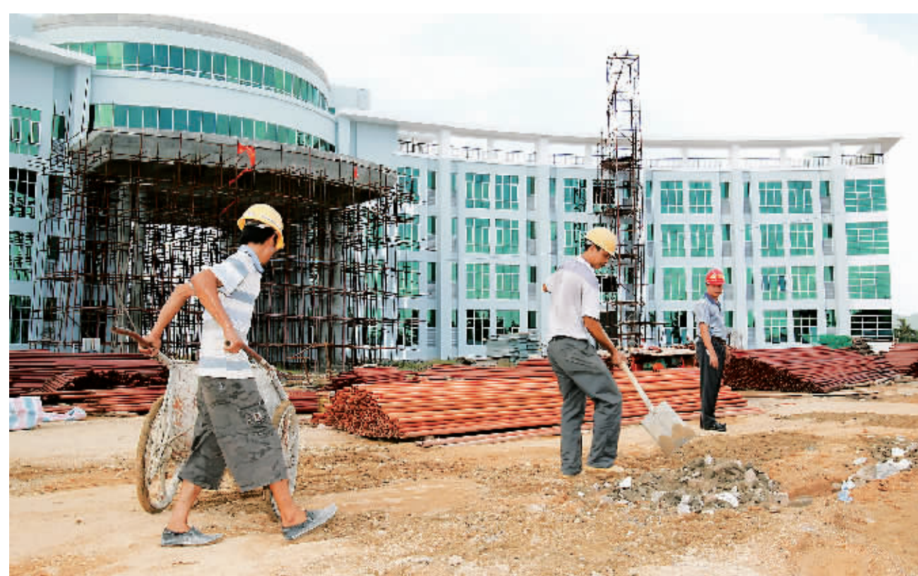
在陵水养老服务中心,工人正在进行主体工程外围施工。据了解,作为目前我省最大养老服务中心,该项目计划投资9000万元,占地126亩,建筑用地面积81.7亩。
