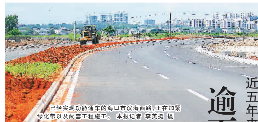
已经实现功能通车的海口市滨海西路,正在加紧绿化带以及配套工程施工。本报记者 李英挺 摄
