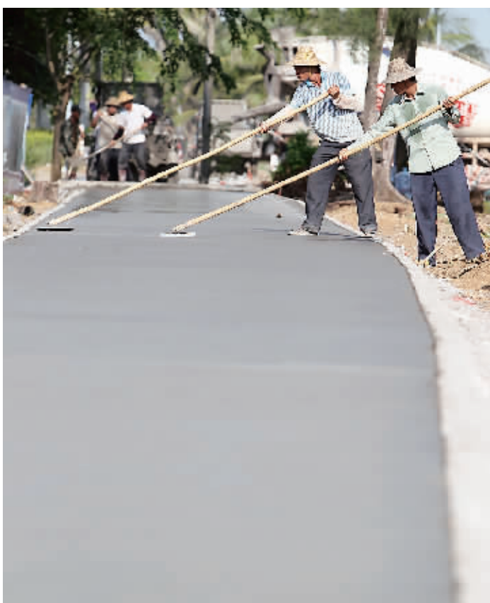
海口西海岸建绿色慢行道
