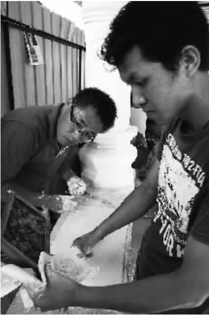
灰塑工人夏湘宸(右)和史亮在制作立面灰塑装饰图案。 本报记者 陈耿 摄
