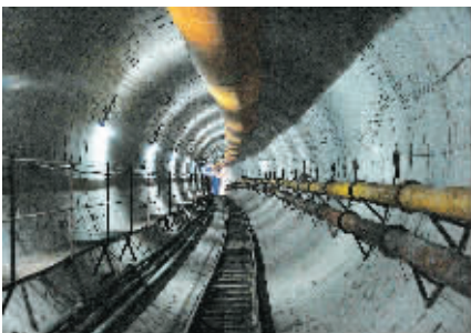
这是9月21日拍摄的武汉地铁2号线越江左线隧道。
