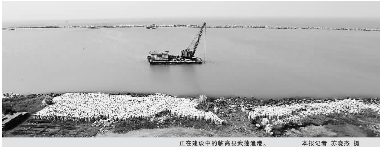
正在建设中的临高县武莲渔港。本报记者 苏晓杰 摄
