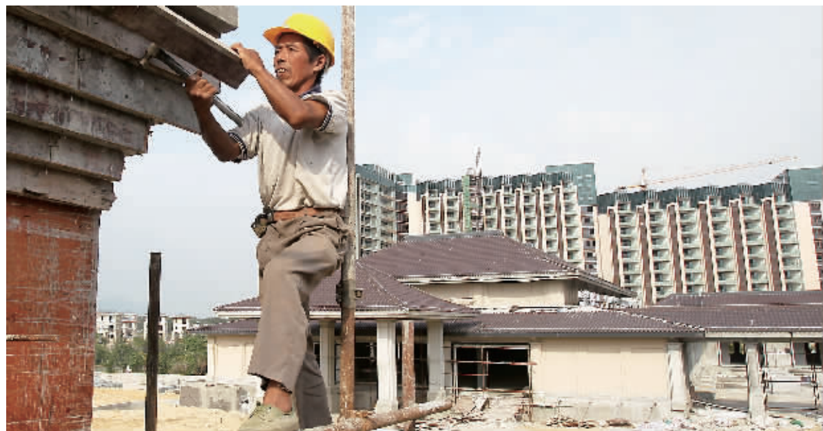
十一月二十四日,陵水清水湾超星级酒店群项目施工正在加紧向前推进。 本报记者 李英挺 摄
