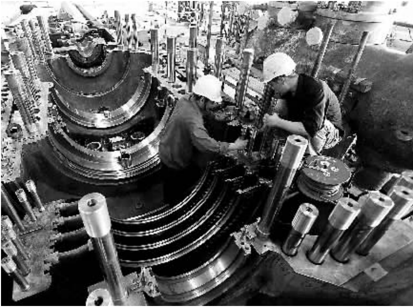
11月29日，华能海南东方电厂二期工程施工现场，工人正在安装3号机组的汽轮机。
