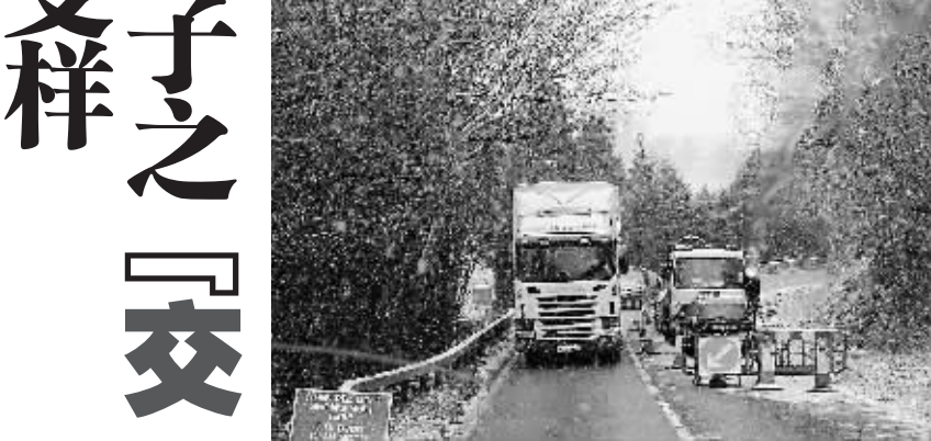
在英国威尔士卡迪夫，一条双向两车道的公路上，一条车道临时维修，施工方架起临时红绿灯，指挥两边车辆有序通过，避免拥堵。
