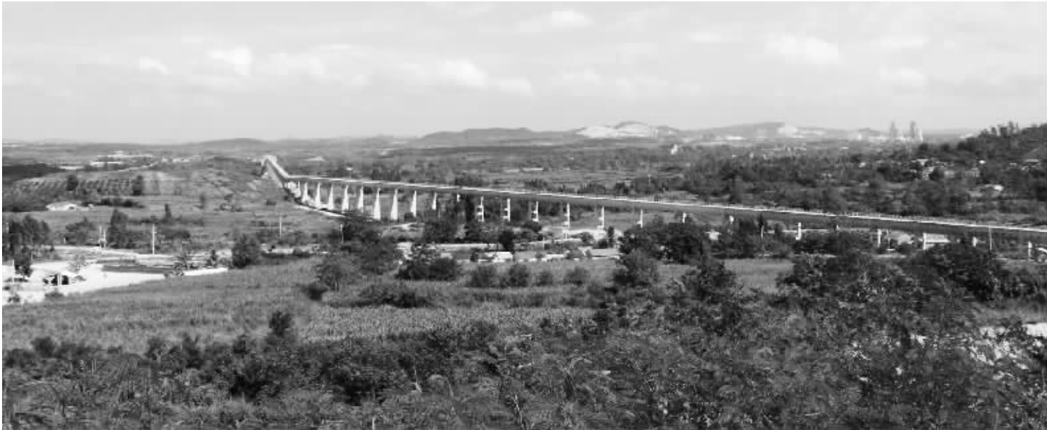
图为昌江干渠 1.7 公里大渡槽
