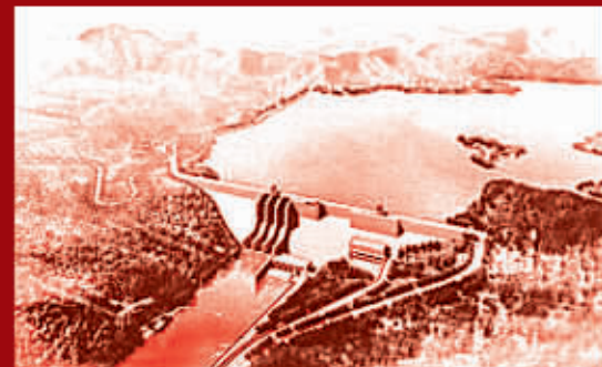
位于琼中县中平镇境内，总投资 25 亿多元，以城乡供水和农业灌溉为主，兼防洪、发电等综合利用的红琼水利枢纽工程
