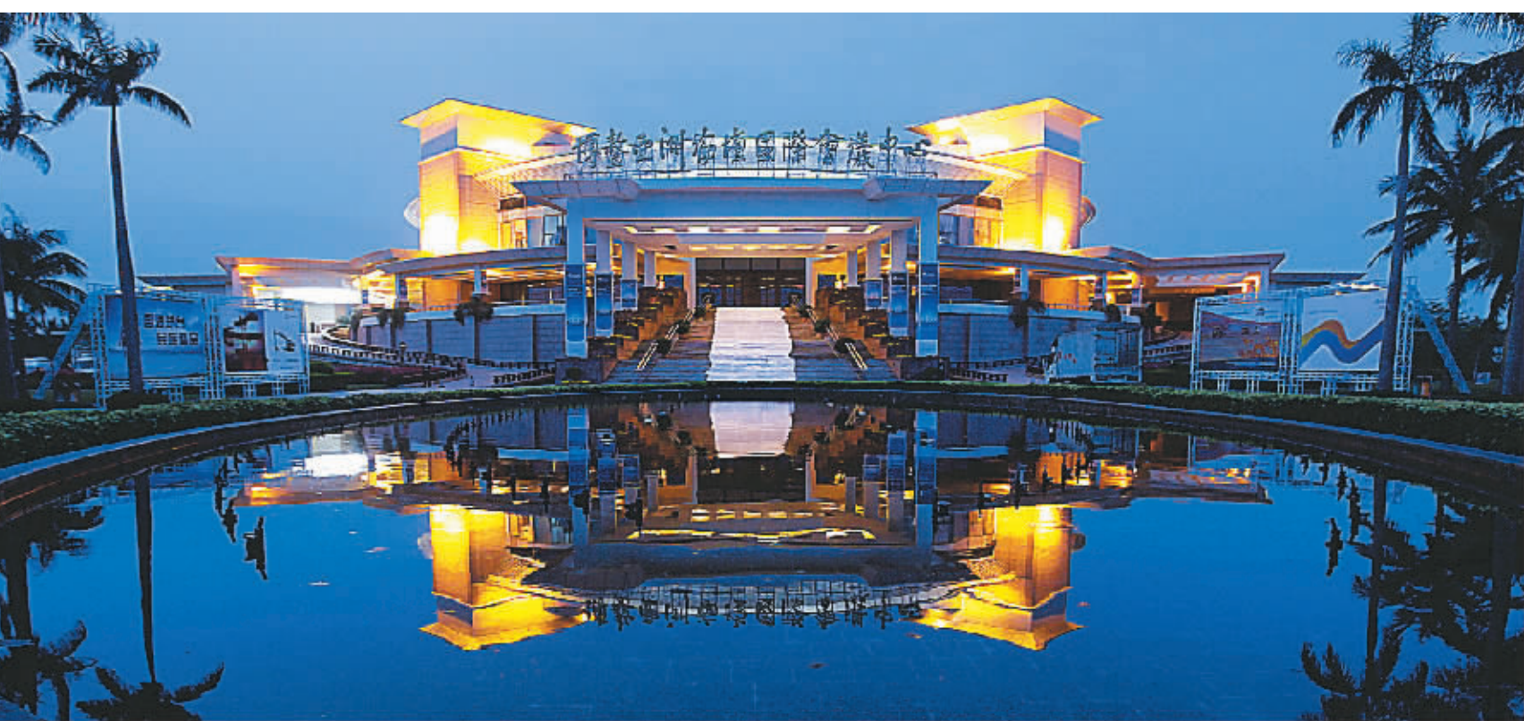
截至3月30日,论坛有关维修布置、安保、服务、通信、保电、卫生等各项工作均已准备就绪。图为博鳌亚洲论坛国际会议中心外景。
