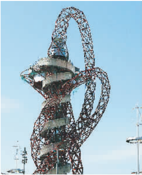
伦敦奥运会场馆的建设体现着环保的理念。这是伦敦奥林匹克公园奥林匹克体育场外的光环桅杆。其中设置的风力涡轮构造可以进行发电,为圆顶照明灯提供部分电力。新华社发
