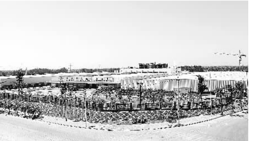
在海口国家高新区狮子岭工业园区内,海南英利光伏生态工业园已崛起新能源之城。(英利供图)
