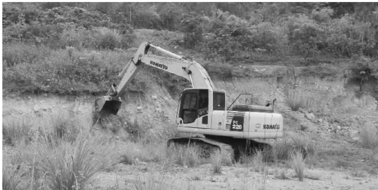
挖掘机进场平整土地。
