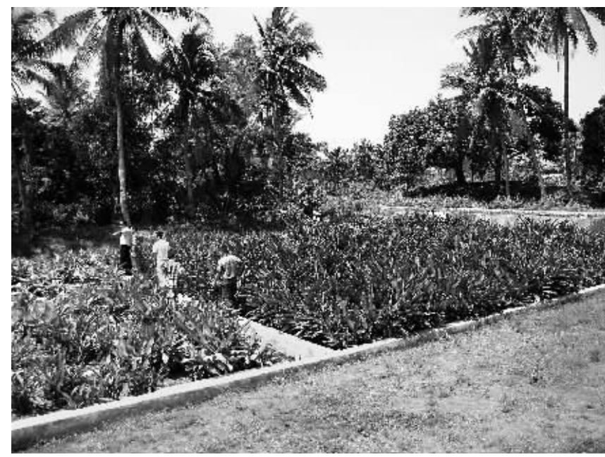
人工湿地污水处理技术的推广,是我省村镇生活污水治理的新突破。图为定安县新竹镇卜优村人工湿地污水处理工程。
