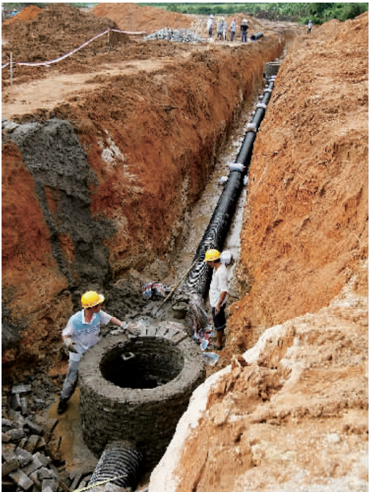
六月一日,在文昌铜鼓岭国际生态旅游区内,宝陵南路段工程项目的施工现场,工人正在铺设排水管。
