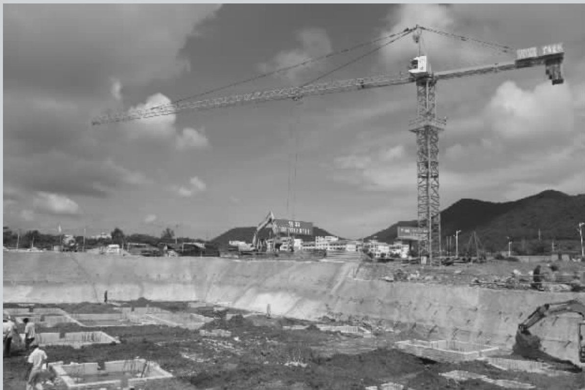
顶着烈日施工
