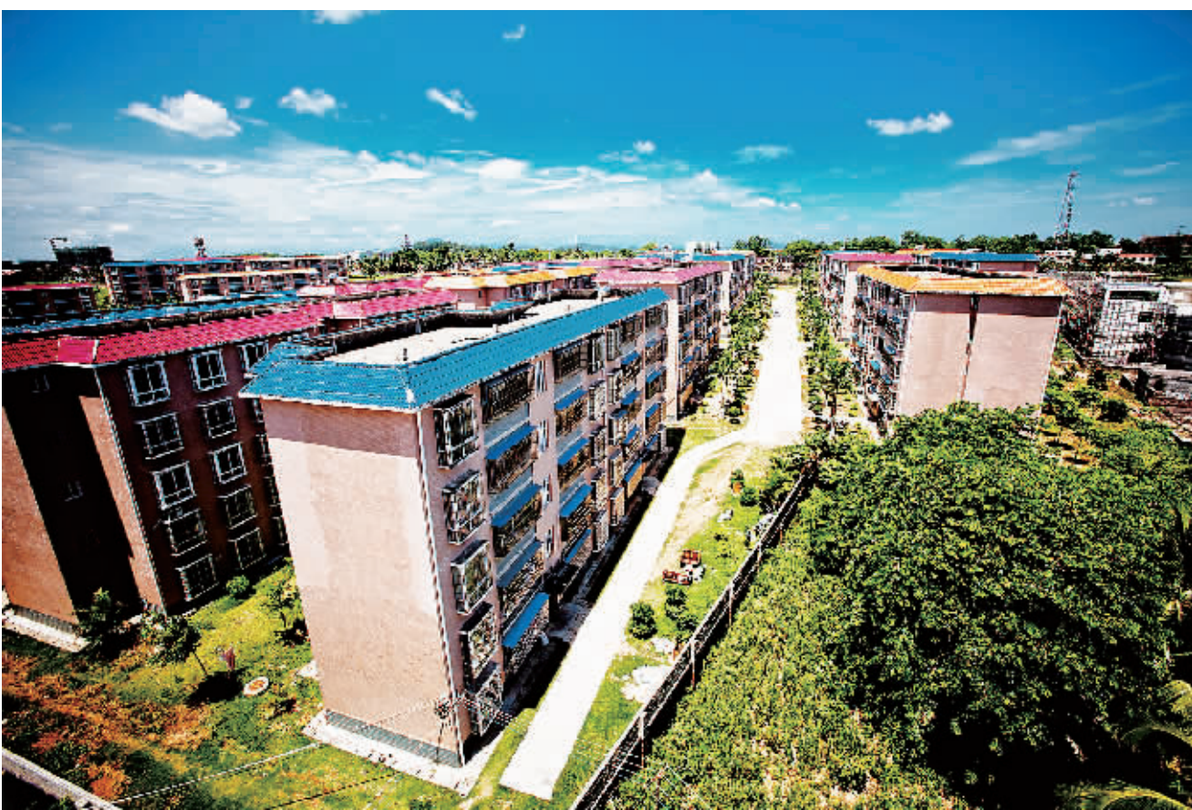
6月14日,西联农场新建红卫职工住宅区,目前小区一期工程600套住房已交付使用。
