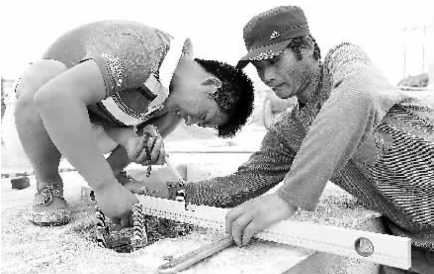
工人在瑞图明盛环保建材(昌江)有限公司项目工地施工。 本报记者 苏晓杰 摄
