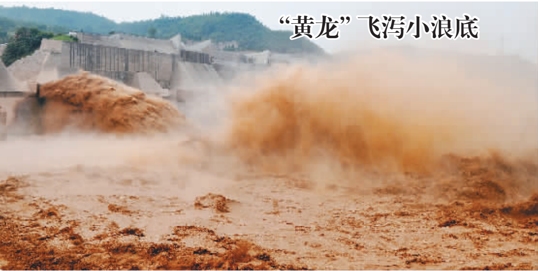
黄河小浪底水库泄洪的壮观景象。黄河干流1号、2号洪峰日前抵达小浪底库区,小浪底水利枢纽打开3个闸门加大泄洪量,加强对洪峰的调节,裹挟着泥沙的水流从小浪底出水口排沙洞喷涌而出,场面十分壮观。
