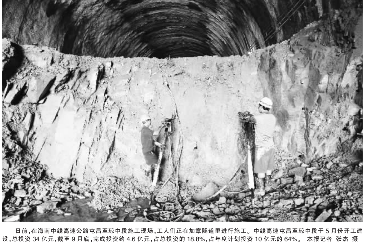
日前,在海南中线高速公路屯昌至琼中段施工现场,工人们正在加章隧道里进行施工。中线高速屯昌至琼中段于5月份开工建设,总投资34亿元,截至9月底,完成投资约4.6亿元,占总投资的18.8%,占年度计划投资10亿元的64%。本报记者 张杰 摄
