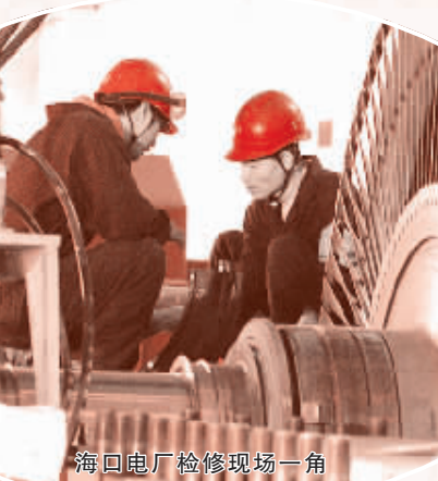
海口电厂检修现场一角
