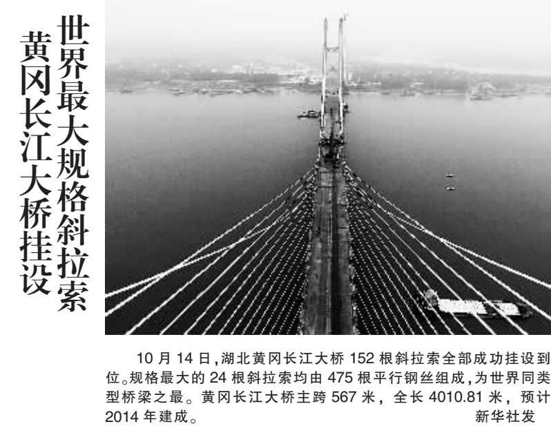
10月14日,湖北黄冈长江大桥152根斜拉索全部成功挂设到位。规格最大的24根斜拉索均由475根平行钢丝组成,为世界同类型桥梁之最。黄冈长江大桥主跨567米,全长4010.81米,预计2014年建成。 新华社发
