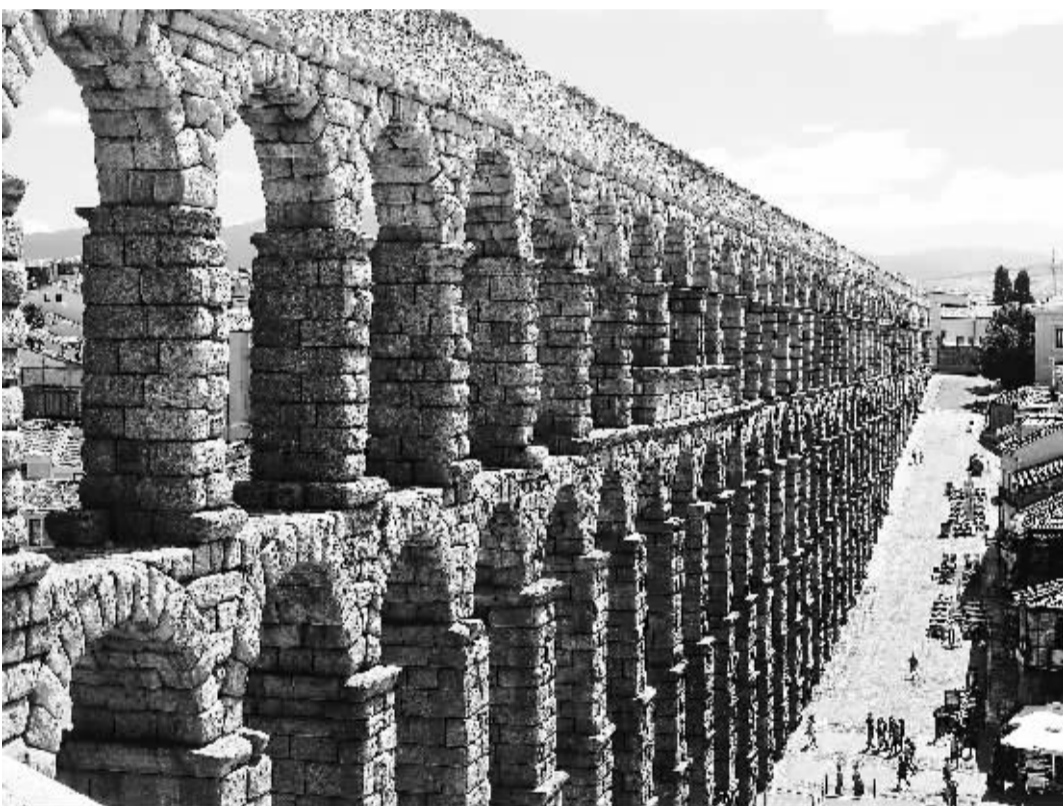
西班牙塞哥维亚 2000 年前修建的雄伟高架渠。
