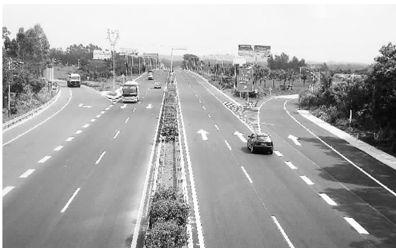
西线高速公路白莲立交至白马井立交段改建工程10月23日正式建成通车,这是我省首条实施施工标准化的重点公路建设项目。
