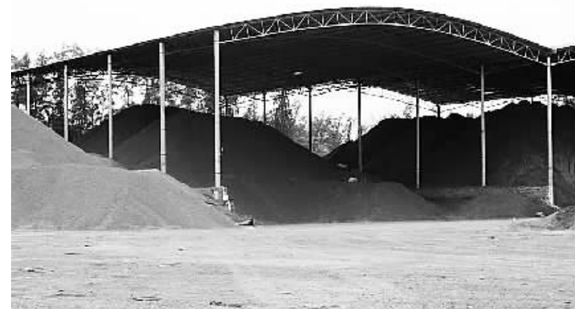
堆料场加盖了雨棚
