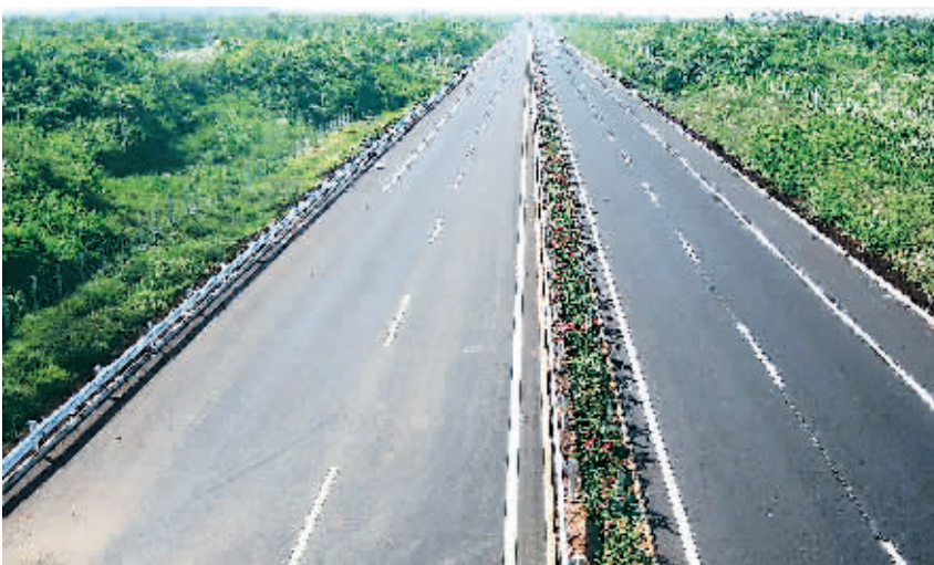
海屯高速公路全新的沥青混凝土路面穿行于青山绿水间。 本报记者 侯小健 摄
