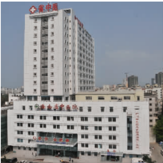
海南省中医院门诊病房综合楼。
