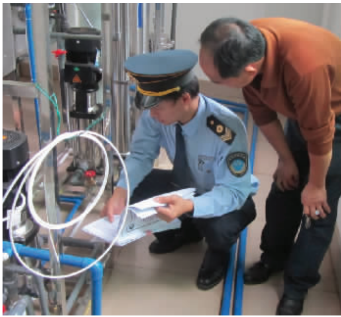
卫生监督执法人员对某学校管道直饮水涉水产品进行现场核查。
