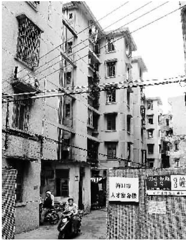
海口大同一横路3号3幢,原名人才楼。见习记者 武威 摄
