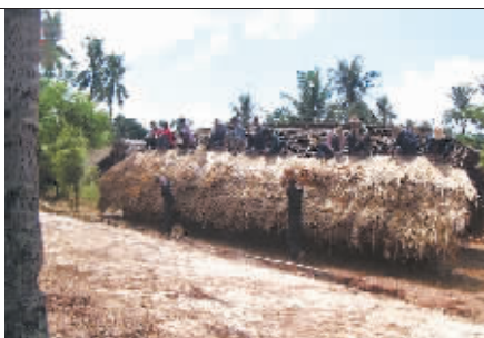
黎族船型屋营造技艺,古老、独特的建筑技艺,为形如舟船倒扣状的茅草屋,冬暖夏附设有隆闺、谷仓。
