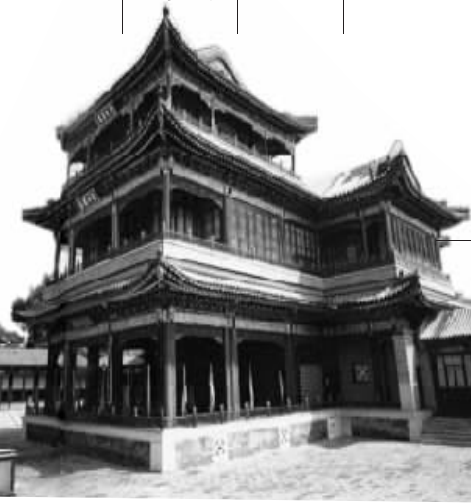
德和园是专为慈禧看戏建造的一组院落,院内坐落着中国现存最大的古戏楼。
