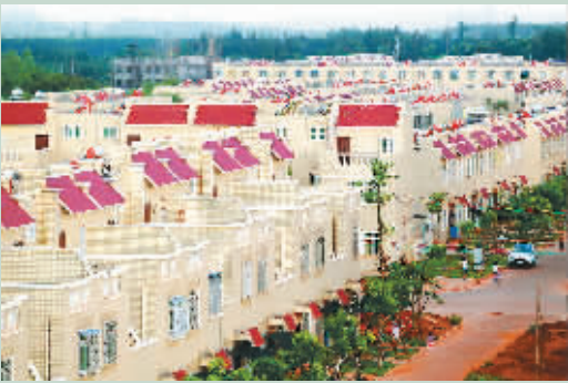
洋气整齐的文昌航天城安置区。
