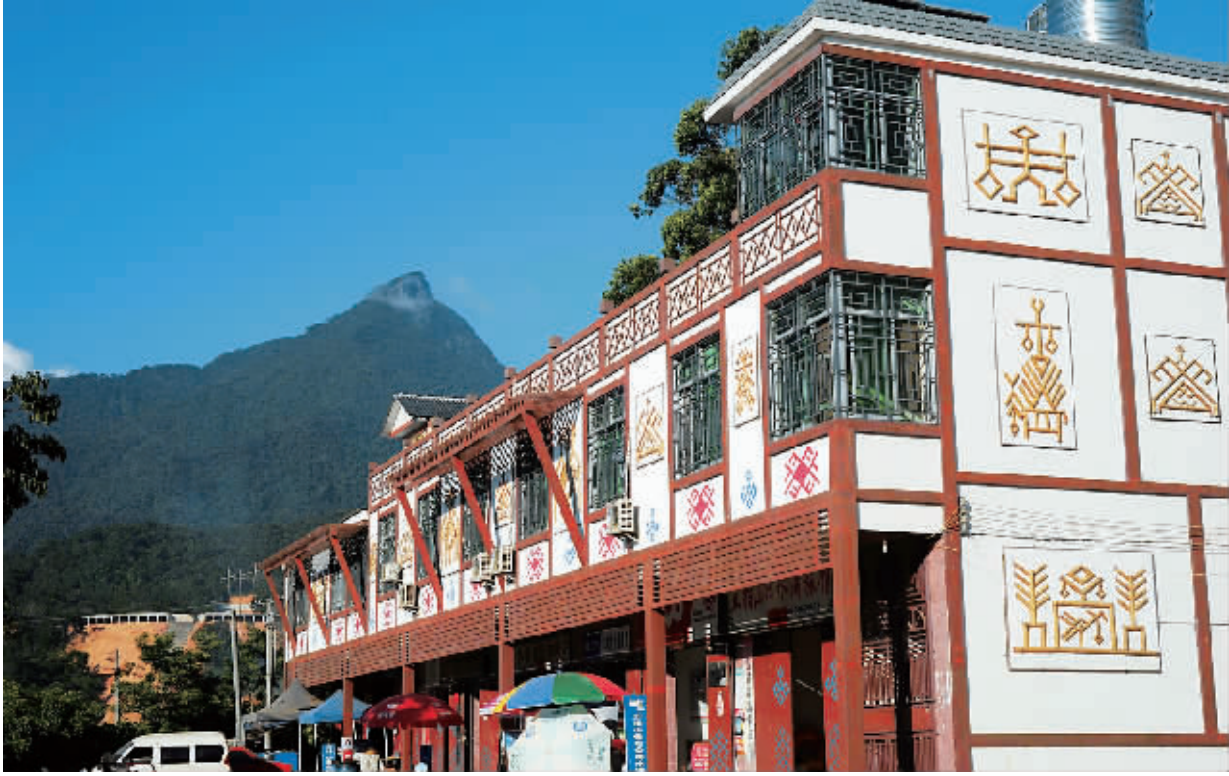
山间吹起民族风 7月2日，位于五指山山麓的五指山市水满乡街道立面正在进行全面改造，一条充满民族风情的商业街蜿蜒在满目青翠的群山间，犹如世外桃源令人神往。 本报记者 苏建强 摄
