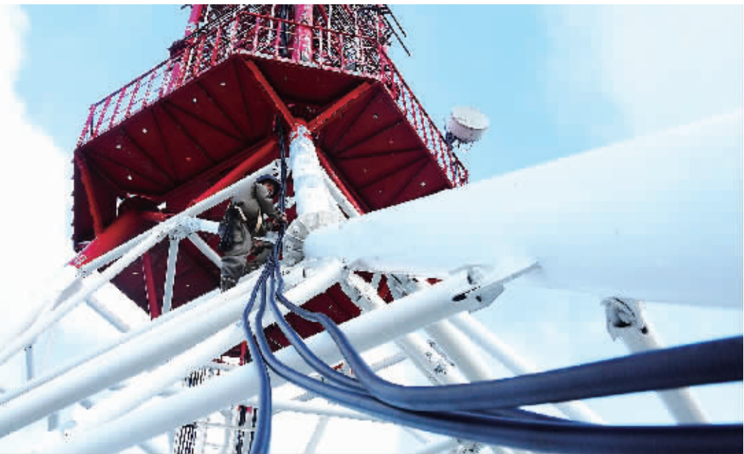
网络工程师在西沙永兴岛电视台基站上安装天馈线。
