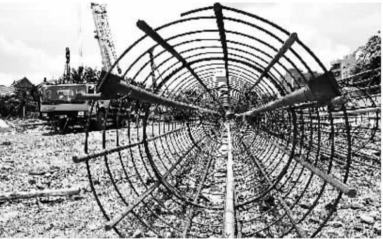
红城湖延长线加紧施工
