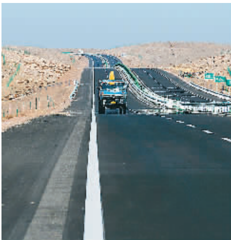
新疆首条沙漠高速公路建设完工
