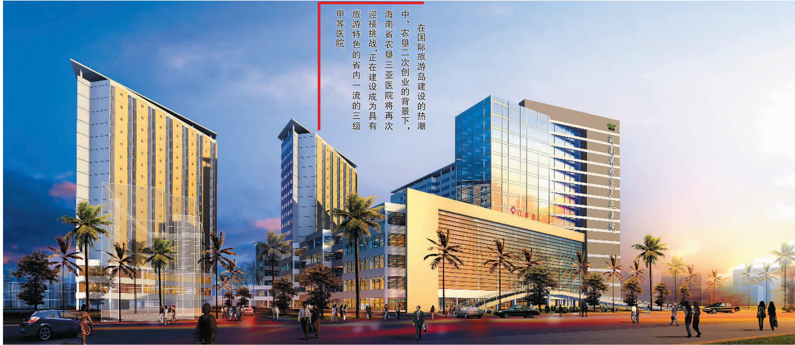
海南省农垦三亚医院新的医疗区升级改造工程已经启动,工程计划分四期完成。目前,一期工程医技病房楼已经基本完工,很快将投入使用。
