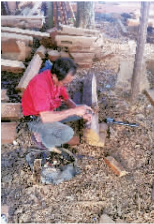
木工王中持正在罗驿村忠烈祠进行修复工作。 杜颖 摄
