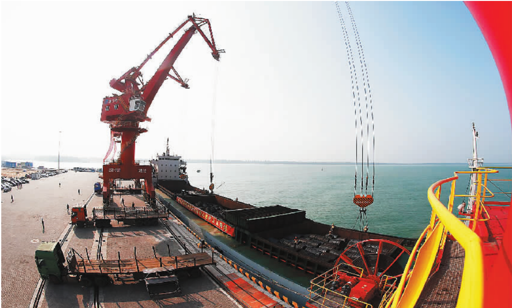
马村中心港区正式开港，标志着海口港秀英港区散杂货搬迁正式启动。
