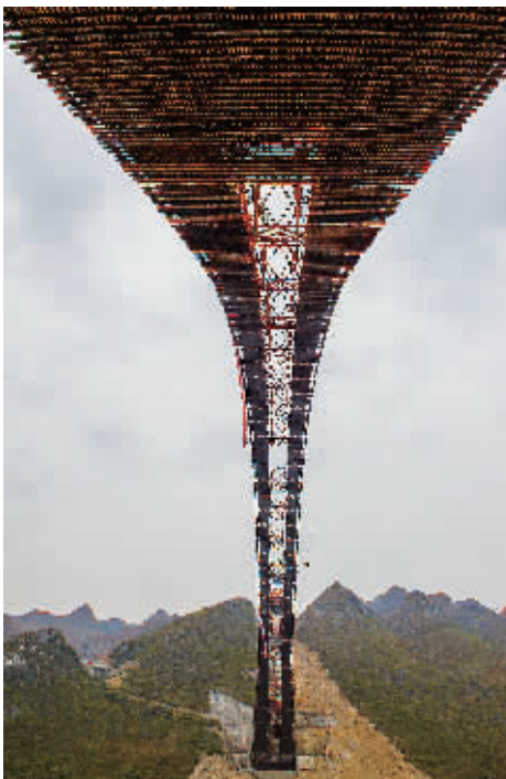
沪昆高铁北盘江特大桥主体合龙 主桥跨度达445米 目前世界同类拱桥中跨度最大
