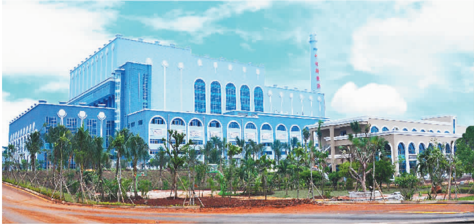
海口环保发电厂外景
