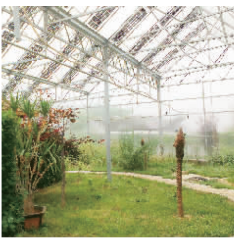
农业光伏示范基地
