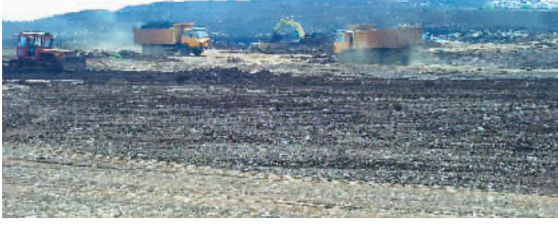
海口环保发电厂二期扩建项目场地平整基本完成
