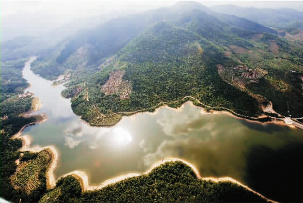
航拍三亚市凤凰镇内的水源地。
