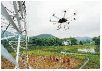
4月26日,多旋翼无人机带着牵引拉线升空。
