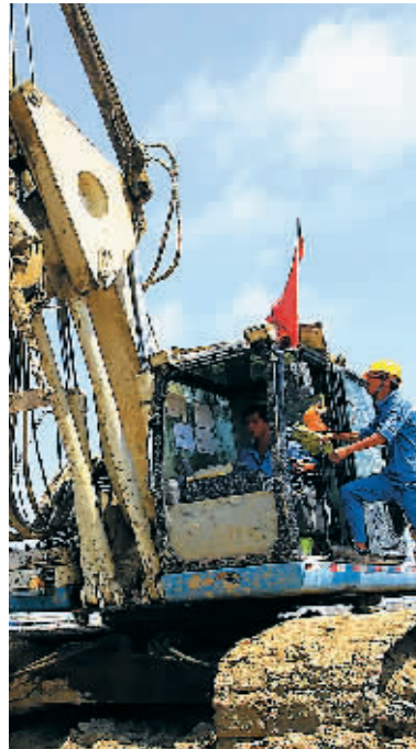
国电海南西南部电厂施工工地现场，旋挖钻孔机械正在施工。 本报记者 武威 特约记者 孙体雄 摄
