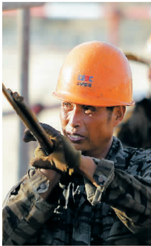
工人高温下抬钢筋。
